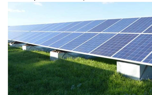
Photographie 3 : Exemple d'ancrage à l'aide de plots en béton posés sur le sol (source : TOTALENERGIES)
