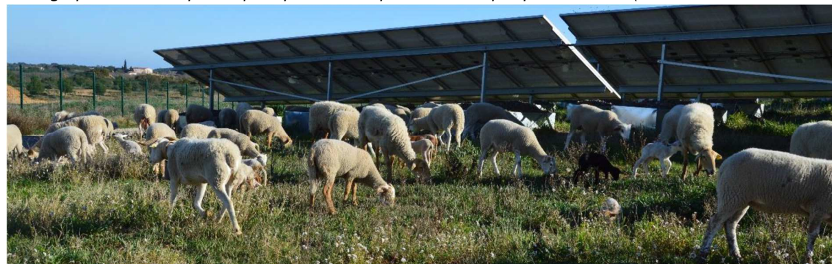
Photographie 7 : Exemple de parc photovoltaïque entretenu par pastoralisme (source : TOTALENERGIES)
