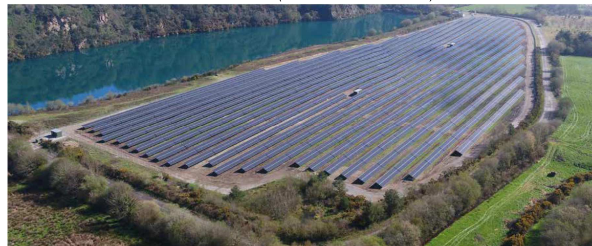
Photographie 1 : Vue aérienne du parc photovoltaïque de Baud (56) conçu et exploité par la société TOTALENERGIES (source : TOTALENERGIES)
