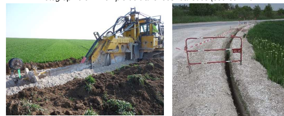
Photographie 6 : Exemple de tranchées réalisées (source : TOTALENERGIES)
