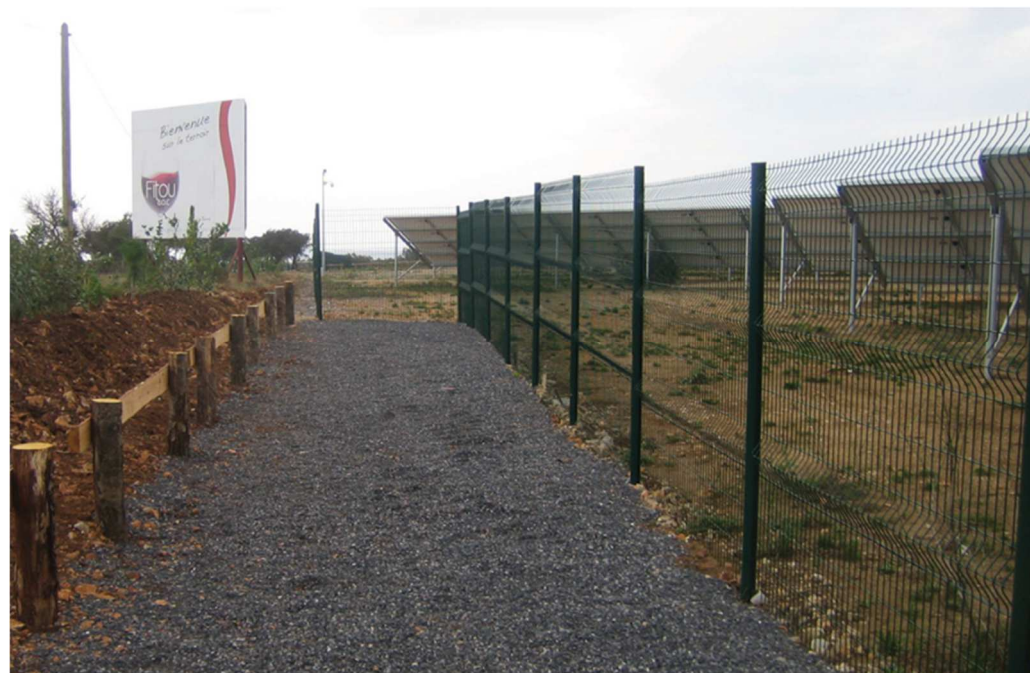
Photographie 5 : Exemples de clôture à grosses mailles d'enceinte d'un parc photovoltaïque au sol (source : TOTALENERGIES)
